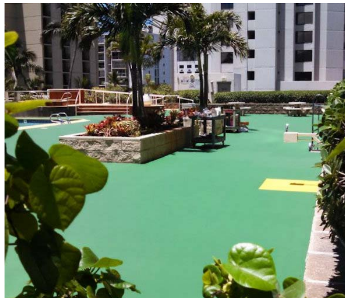
コンクリートが修理再塗装されほとんど作業完了
